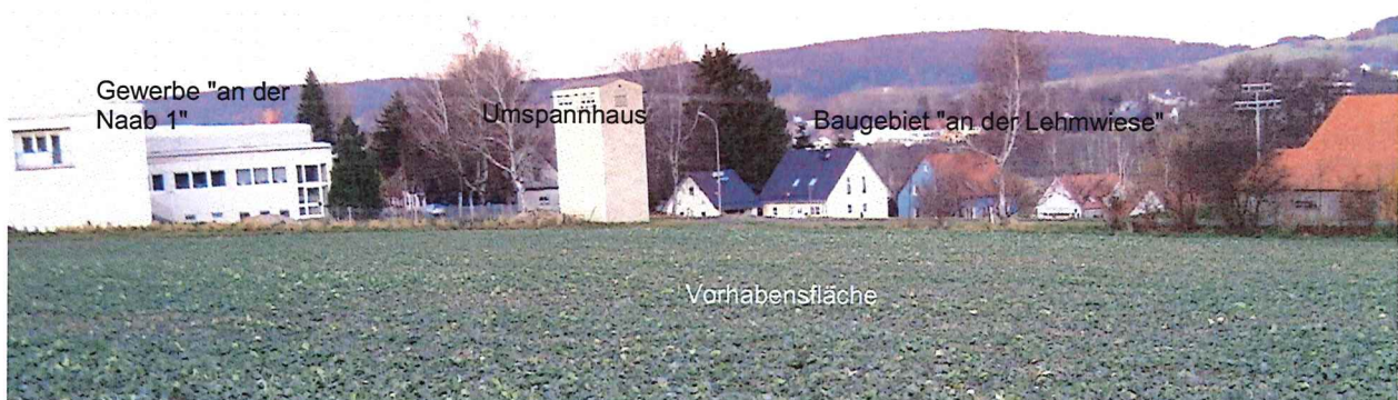
Abbildung 16: nordöstlich angrenzendes Baugebiet an der Lehmwiese
