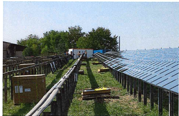
Abb. 5: Beispiel einer Freiflächen-Photovoltaikanlage während der Montage
